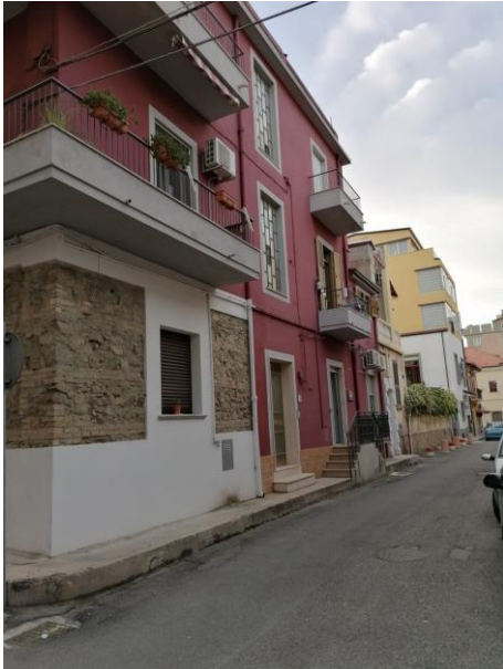
Foto 17: vista delle case di Via Galliano da riqualificare
