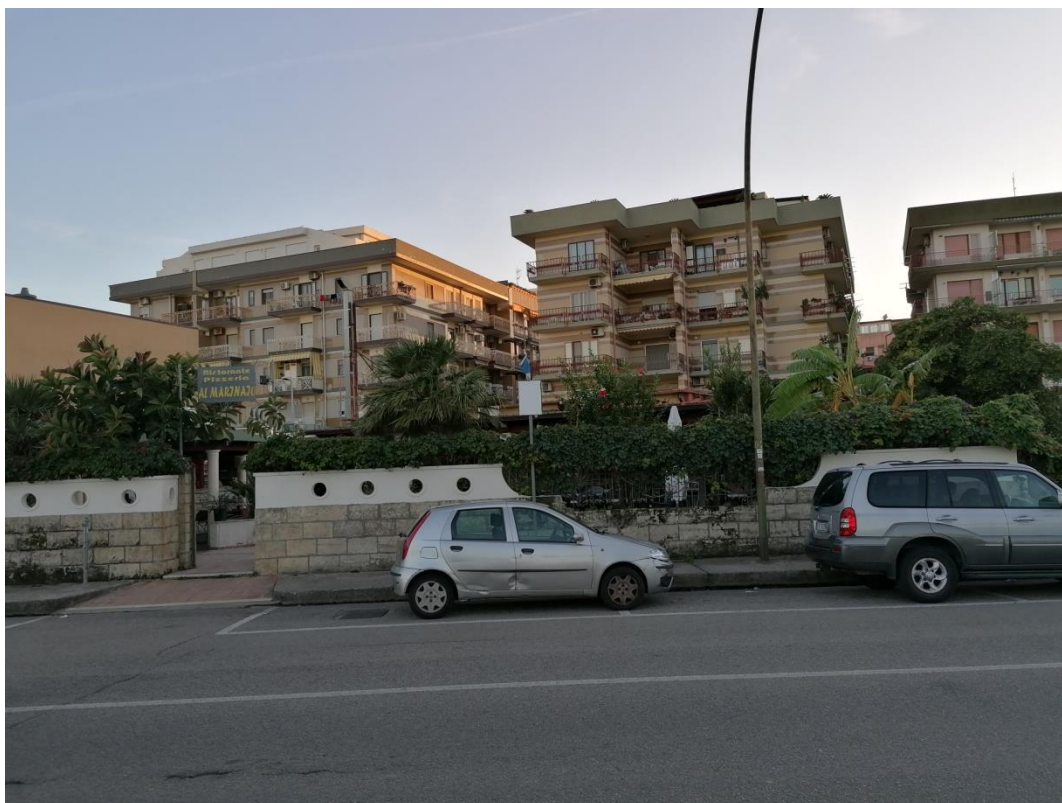
Foto 4: vista dei palazzi prospicienti Via Colombo
